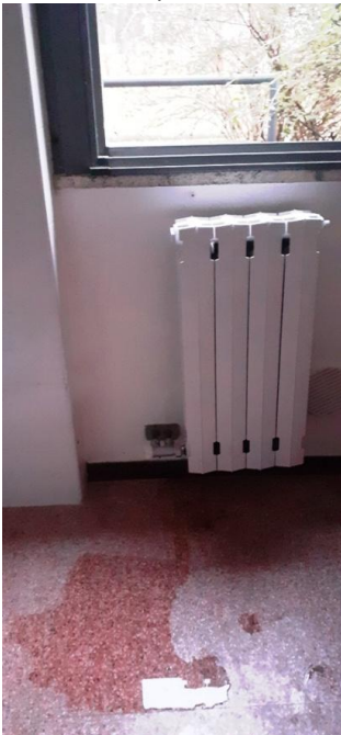
3. Chiudo il Calorifico della zona cucina perché perde acqua così come la Pucci del bagno.. tuttavia in attesa Vs riparazione fotografo il contatore acqua
